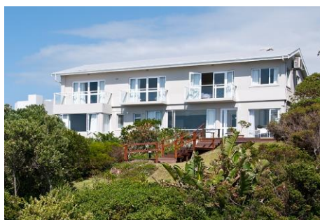
Beach Head Villa Gebäude
